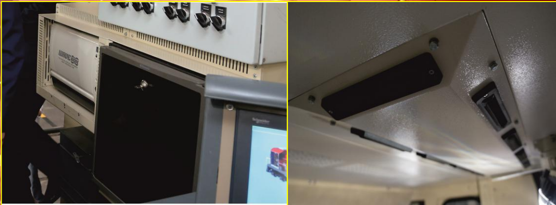
Холодильник, микроволновая печь, кондиционер
